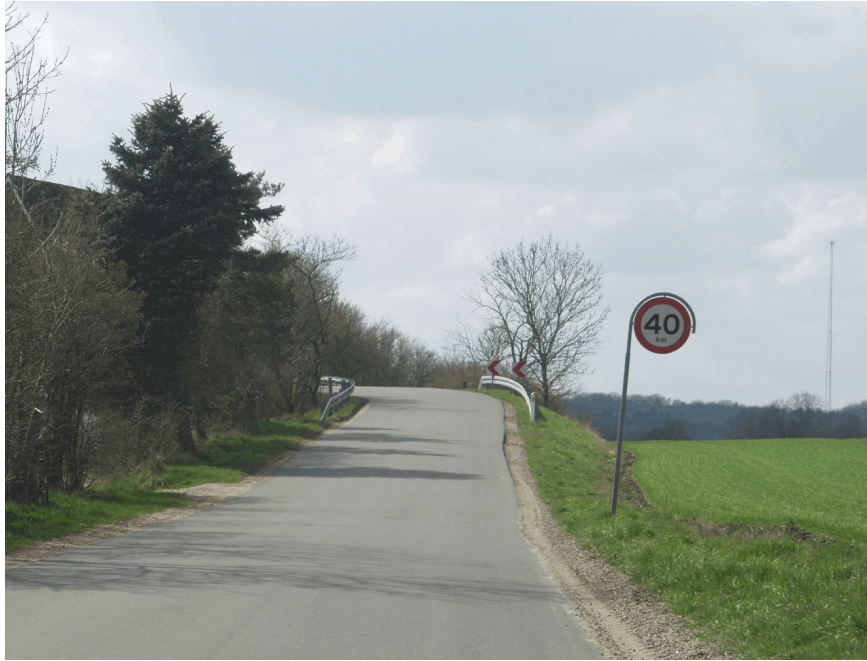
Emborgvej, umiddelbart før jernbanebroen i vestlig retning. Der indføres her en hastighedsgrænsen på 40 km/t.
