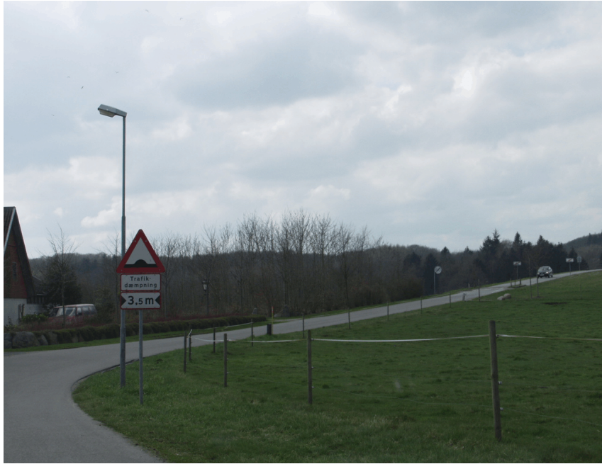
Emborgvej i vestlig retning i udkanten af Alken. Hastighedsnedsættelsen på 40 km/t ophæves.
